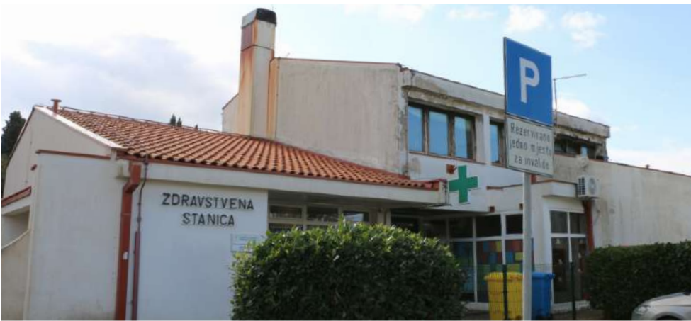
Slika 92. Zgrada vrtića, doma zdravlja i ljekarne u Svetvinčentu
